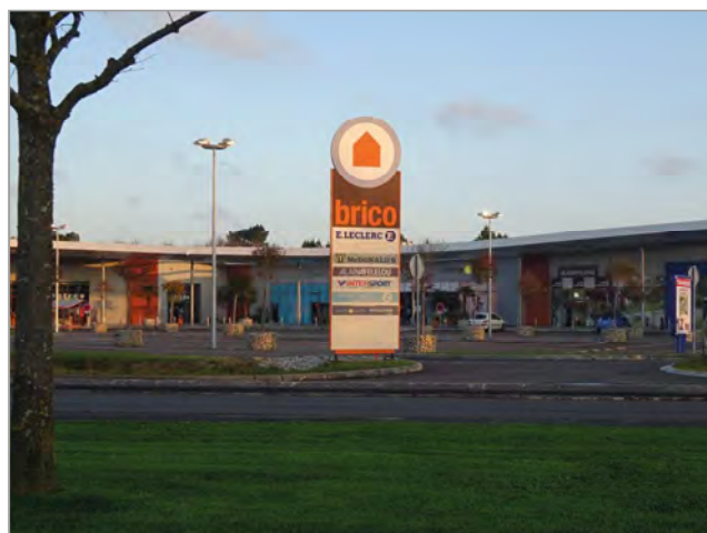
Avenue de la Louadie - Exemple de regroupement sur un même support
