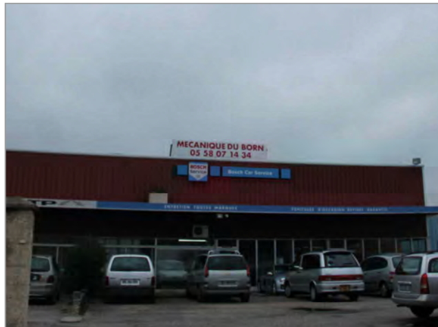
Rue de la Ferronnerie - Enseigne en toiture illégale
