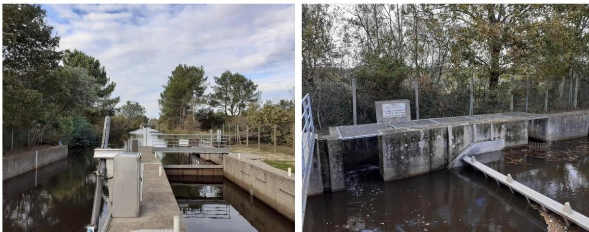
Figure 68 : Ecluse de Navarrosse (à gauche) et sa passe à poissons (à droite)
