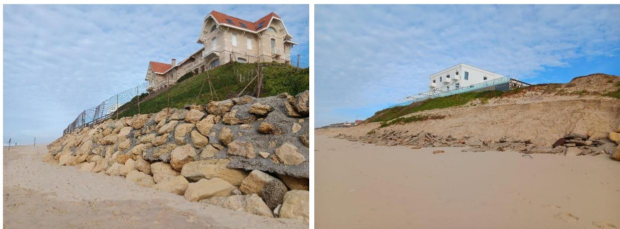
Figure 81 : Etat des ouvrages de protection n°3 et n°4 sur le front de mer en novembre 2023
