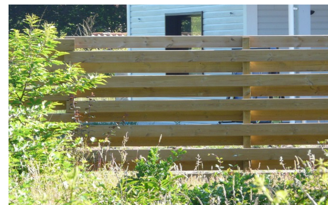
Clôture à claire-voie (à charge des acquéreurs)
