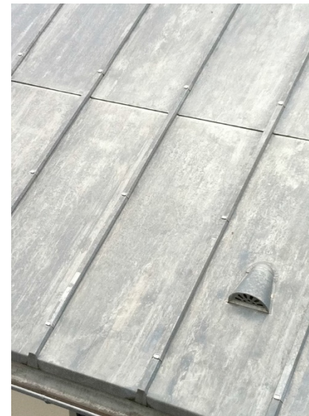
Couverture à joint debout
