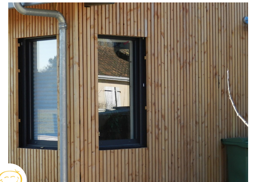
Détail de parement bois : Une mise en œuvre soignée d'un parement bois massif
