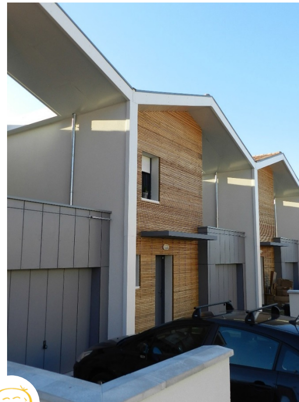
Façade enduit bois : une combinaison maçonnerie enduite et parement bois
