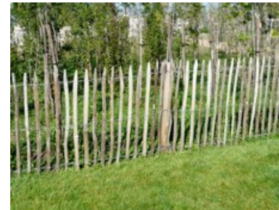
Clôture à échalas en châtaignier dite « clôture girondine » ou ganivelle (à charge de l'aménageur)
