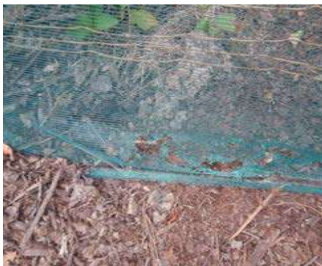
Figure 44 : Exemple de barrière insuffisamment enterrée et matériau peu solide (Source ENVOLIS)
