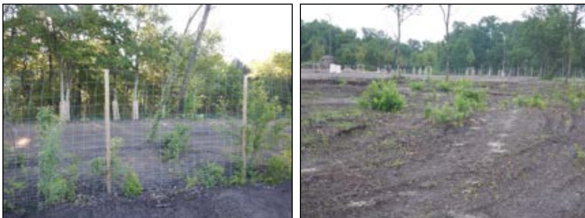
Figure 44 : Développement d'espèces invasives sur chantier après travaux de terrassement (Source : ENVOLIS)
